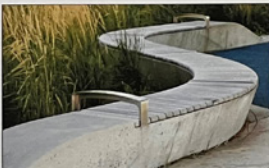
Curved Concrete Seating at Bus Stops Asientos Curvos de Concreto en las Paradas de Autobús
