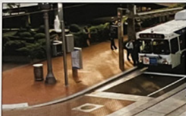
Red Brick Paving for Plaza Pavimento de Ladrillo Rojo para Plaza
